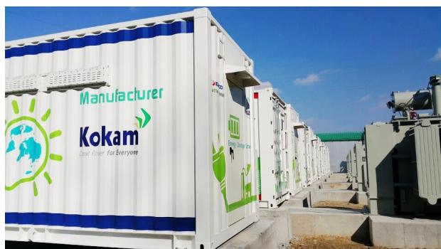
24-мегаваттная система хранения энергии (СХЭ), развернутая компанией Kokam в интересах крупнейшей Южно-Корейской энергетической корпорации KEPCO, стала самой большой в мире СХЭ на основе литий-никель-кобальт-марганцевых аккумуляторов, предназначеннной для стабилизации частоты.
