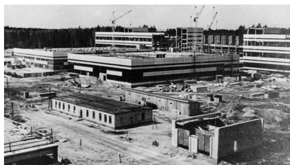
Рисунок 6. Строительство ЭЗАН в 1974 г.
