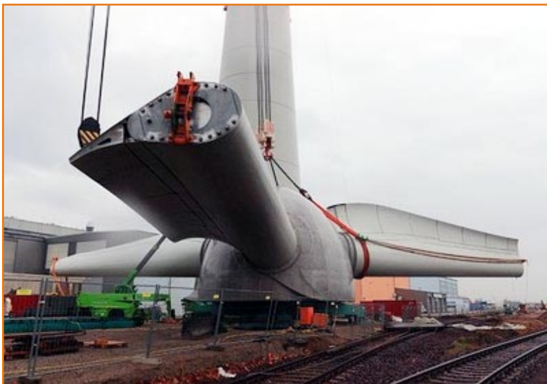
Enercon – единственная фирма в мире, собирающая лопасти своих турбин из двух частей
